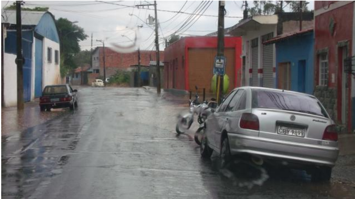
Ponto que alaga devido a falta de drenagem adequada, importante localidade de acesso ao Jd. Santa Cruz
