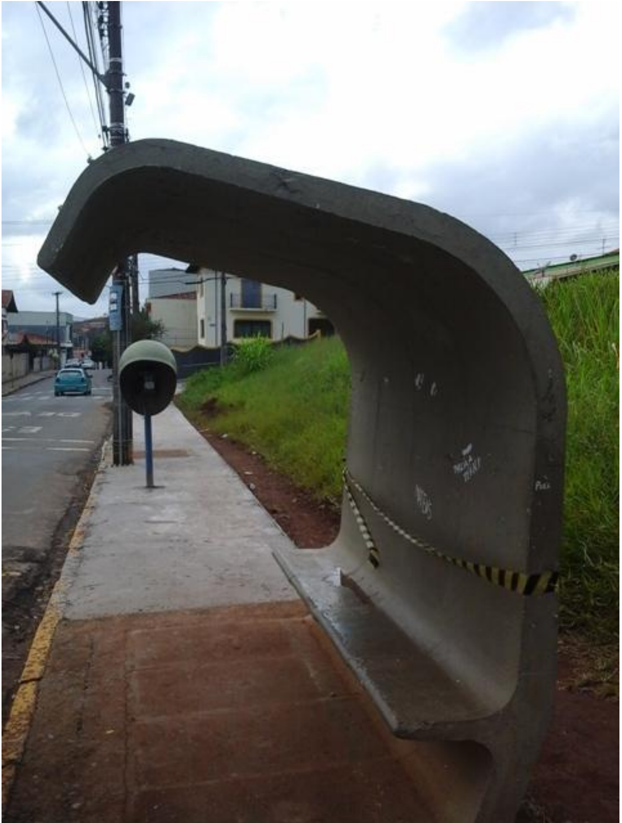
Ponto em concreto com problemas de conservação
