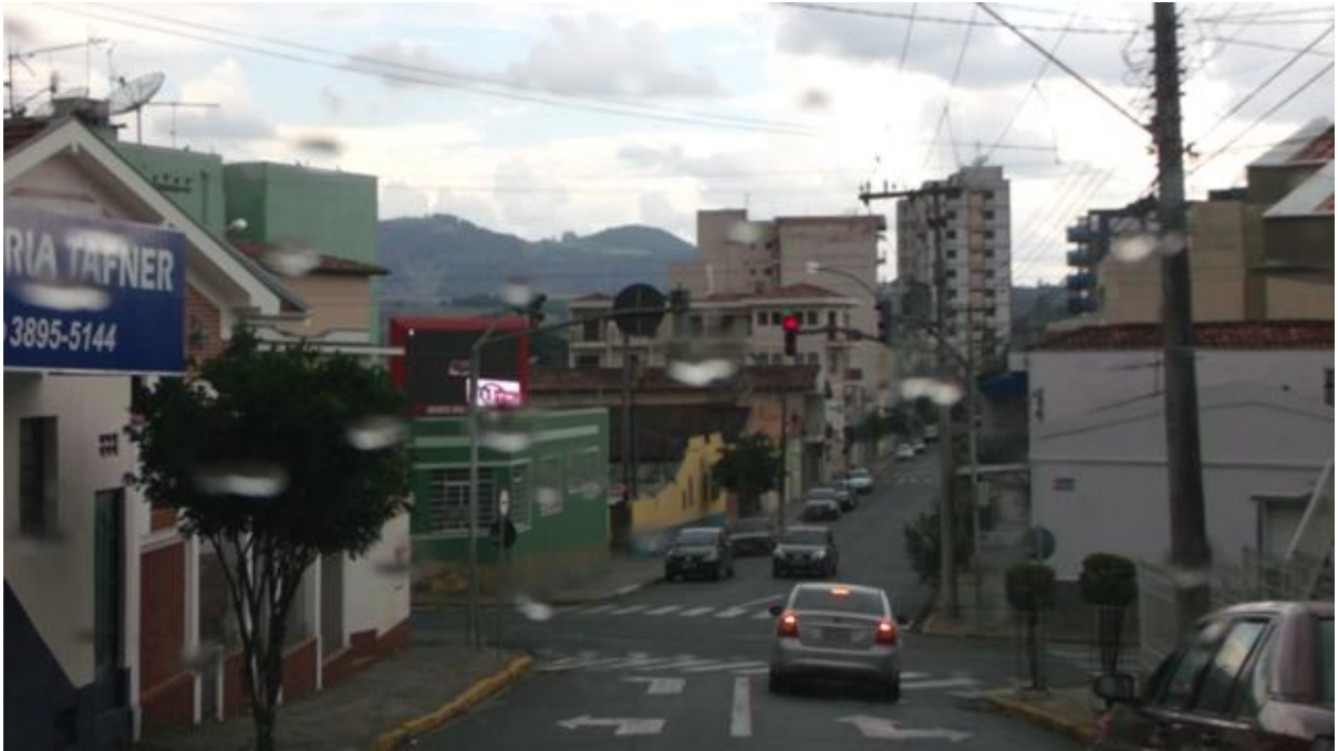
Semáforo com grave problema de falta de foco repetidor que em caso de lâmpada queimada aumenta o risco de acidentes
