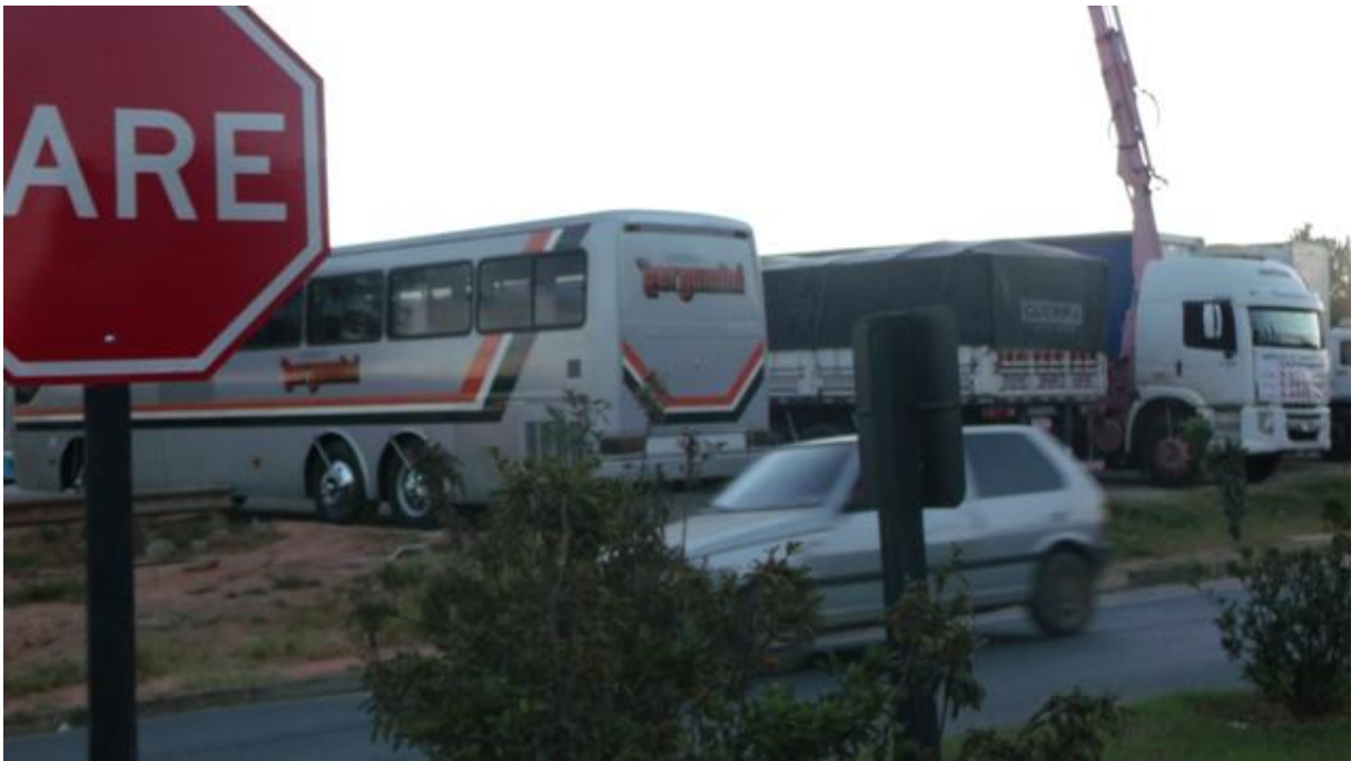
Passagem sob a SP-08 limitando a circulação de ônibus e tráfego pesado aguardando duplicação para melhorar a segurança
