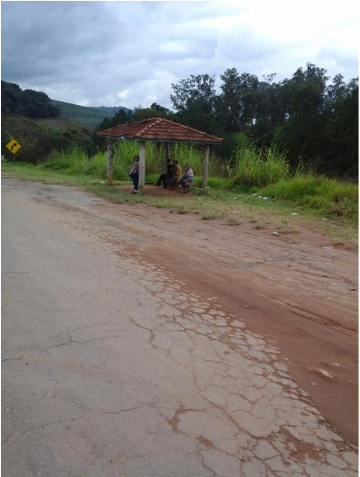
Ponto na SP-08, instalação precária, sem iluminação, com falta de outros itens de segurança entre a pista e o ponto.
