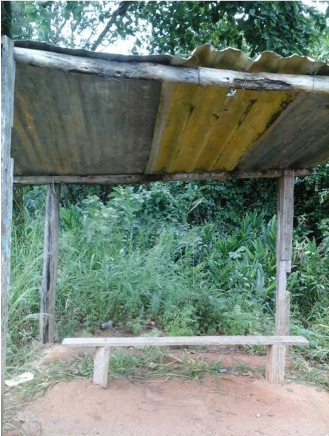
Ponto precário, improvisado e mantido pela população
