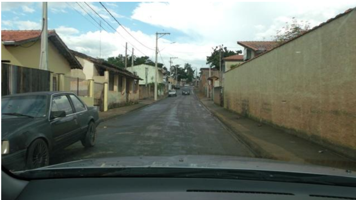
Bairro populoso sem atendimento transporte, rua estreita, calçada precária e sub dimensionada
