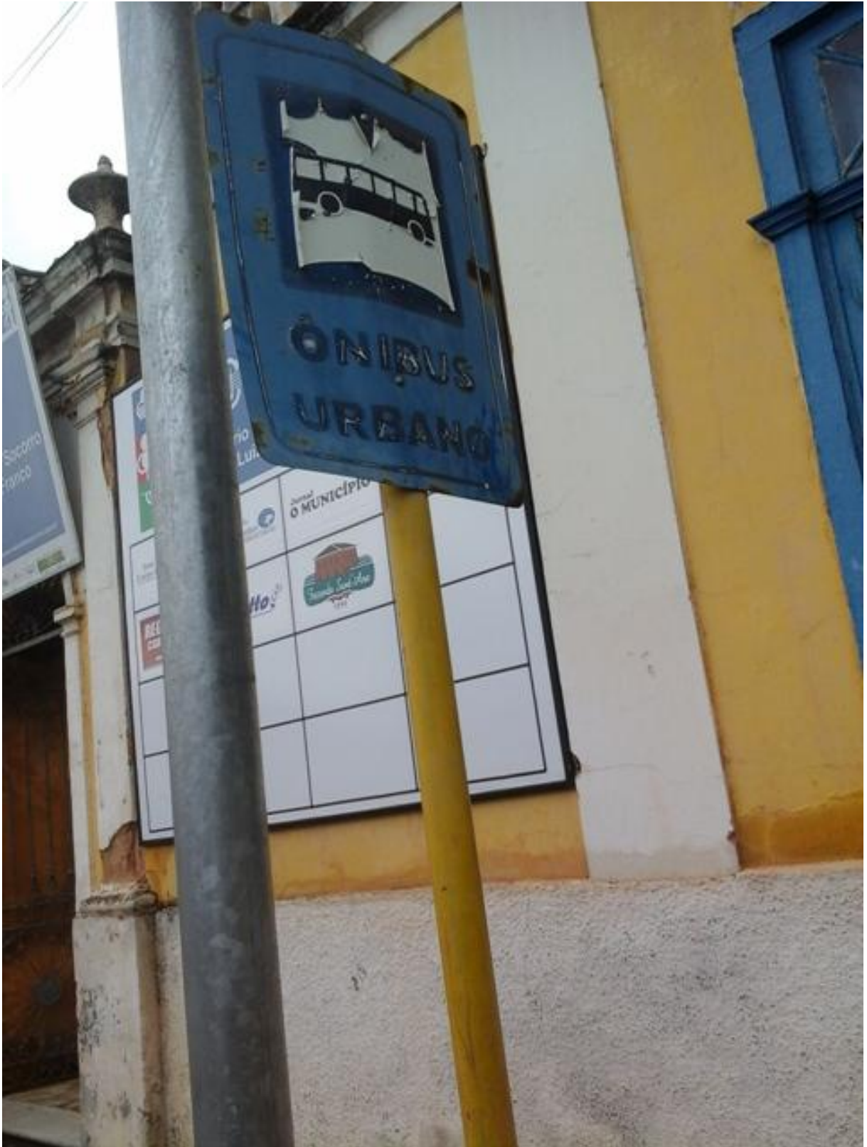
Sinalização do ponto necessitando substituição
