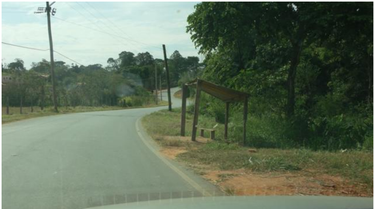
Ponto localizado na curva, sem acostamento/ou baia, com riscos de acidentes de trânsito e por queda do telhado improvisado
