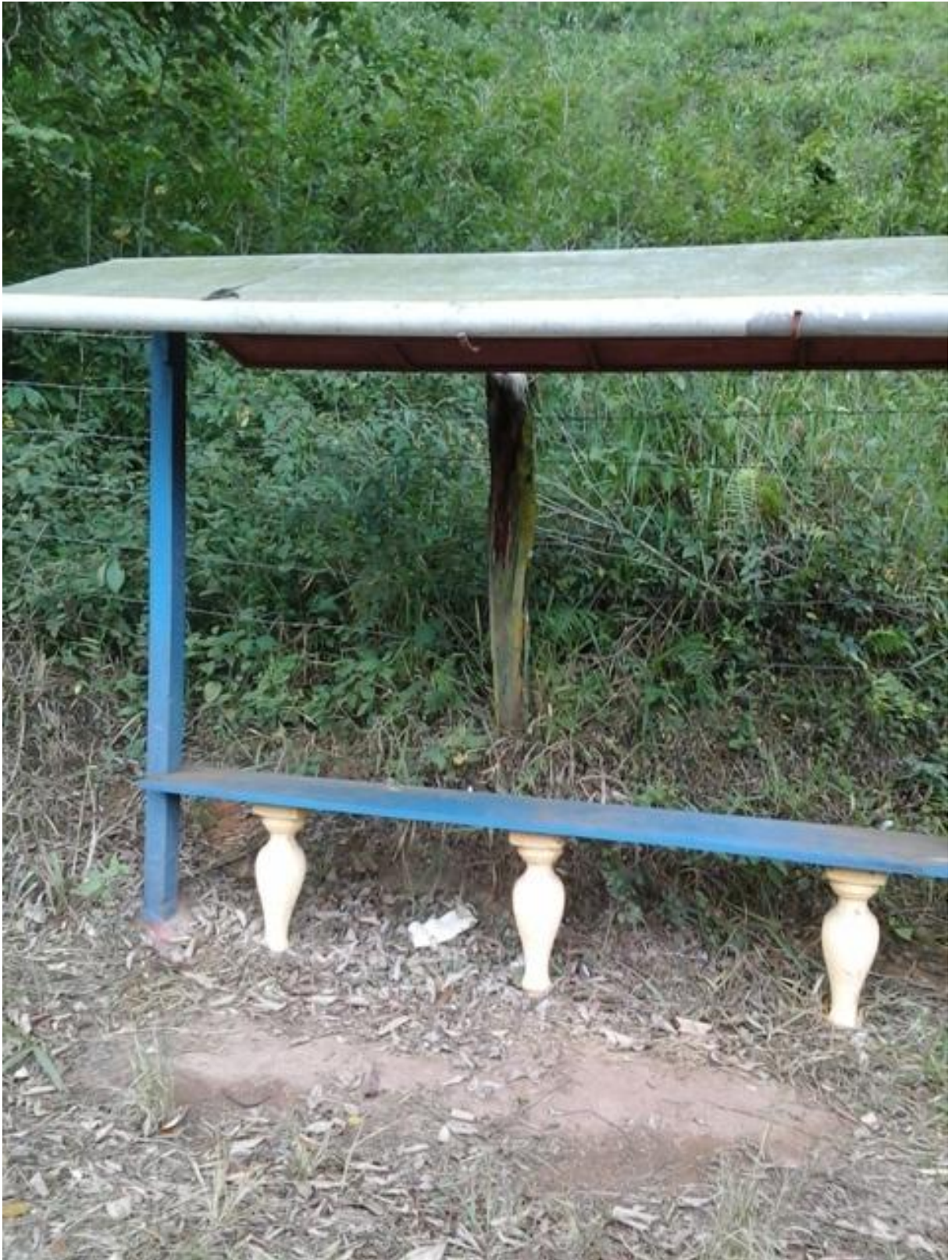
Exemplo da falta de padronização
