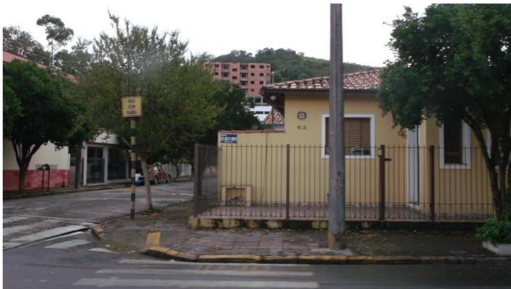
**AI-01 – Necessidade de complementação dos rebaixamentos, conforme a NBR 9050**
