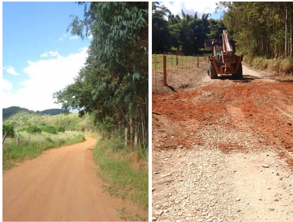
Figura 20: Compactação de cascalho
