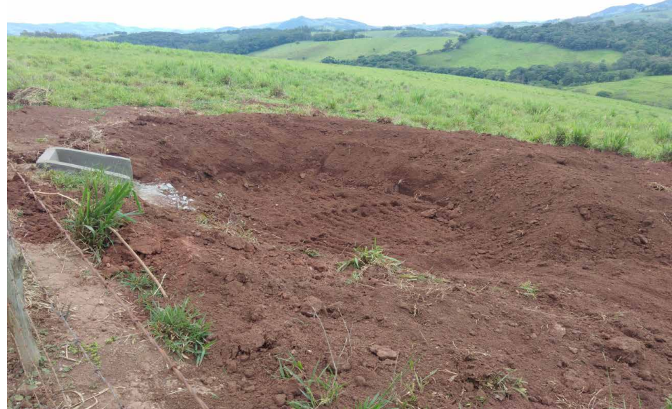
Figura 12: Caixa de retenção
