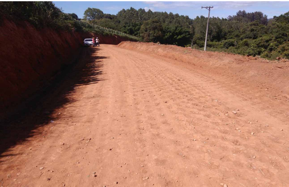
Figura 29: Cascalhamento e compactação da pista
