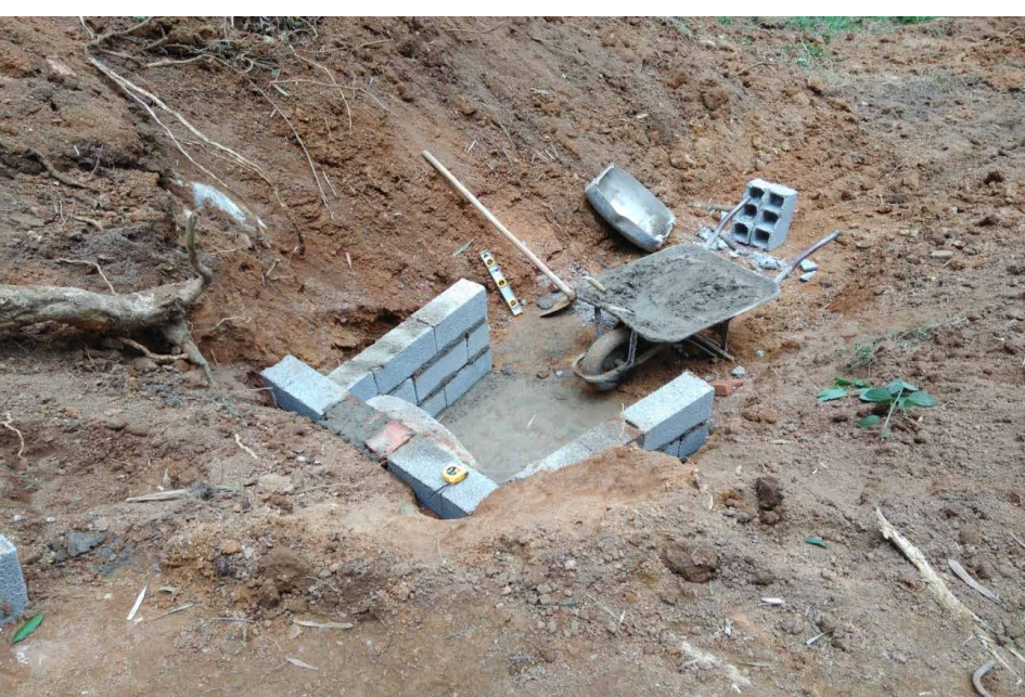
Figura 24: Instalação de tubulação de 0,60m para condução de água pluvial
