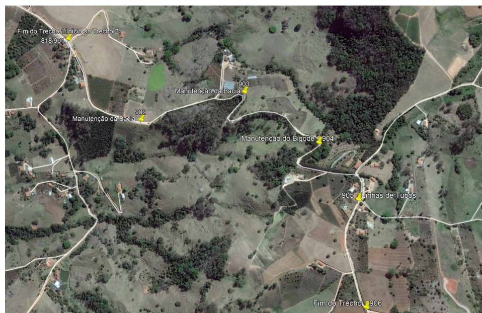
Figura 48: Imagem aérea da Estrada SCR 413 Trecho II
