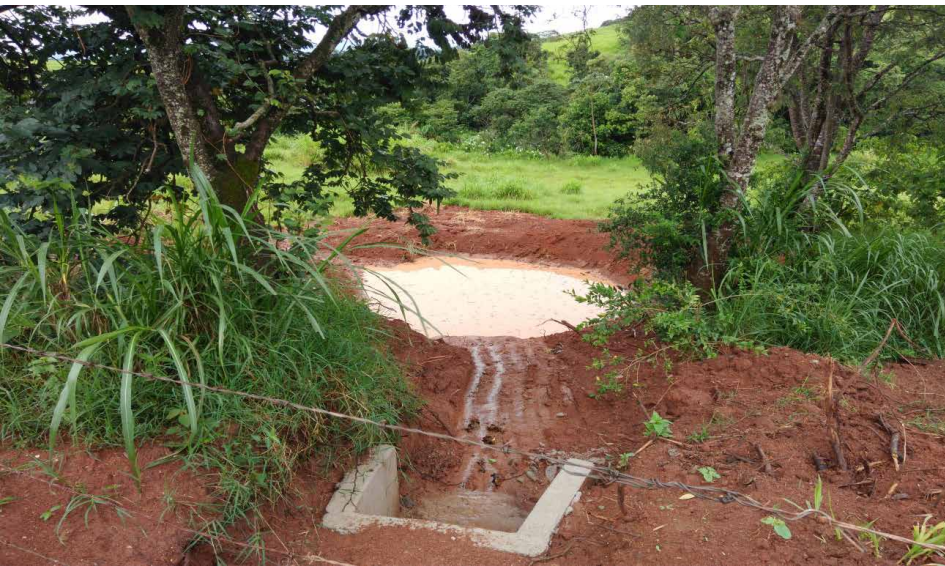
Figura 17: Obra de condução de água pluvial para caixa de contenção
