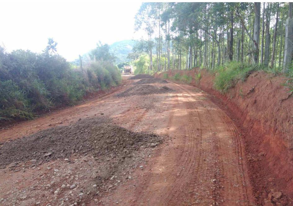
Figura 15: Revestimento primário do leito carroçável
