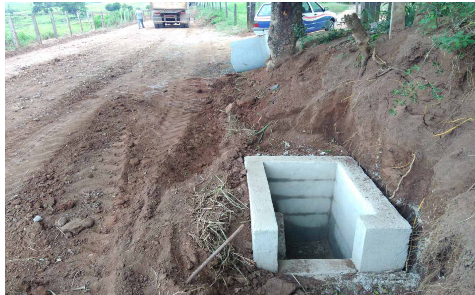
Figura 13: Caixa dissipadora de energia hidráulica
