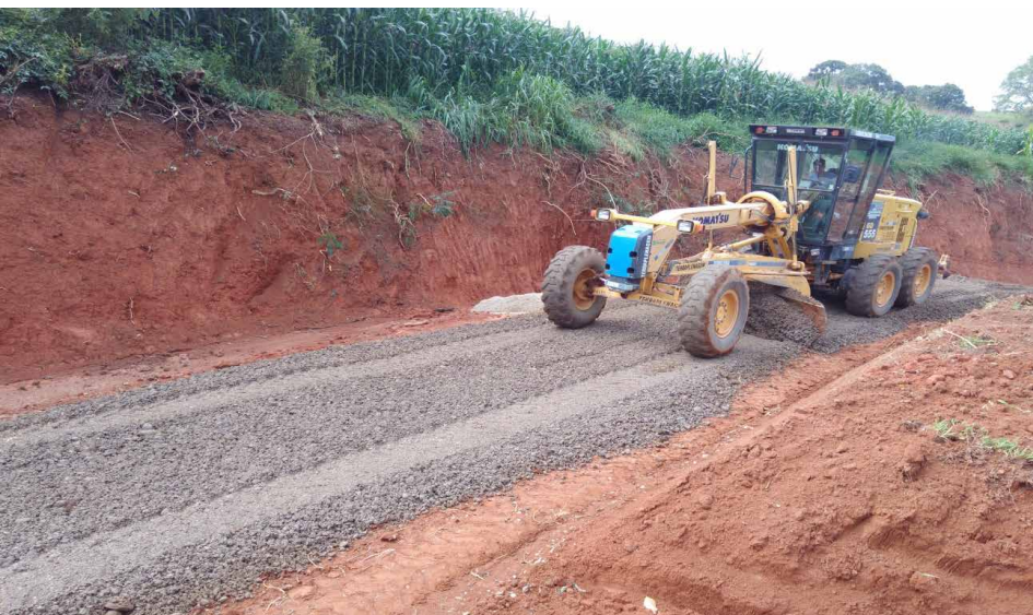
Figura 29: Cascalhamento e compactação da pista
