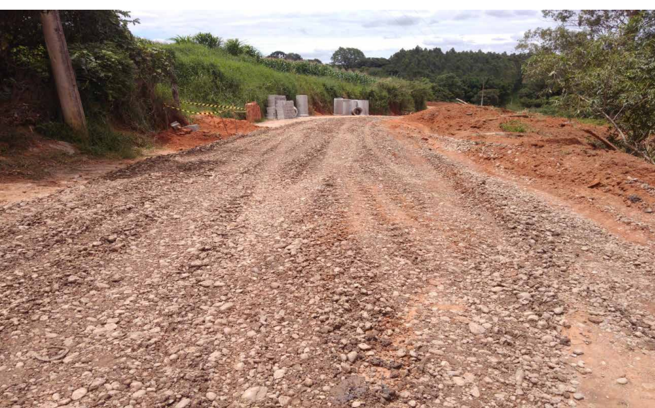
Figura 23: Instalação de tubulação de 0,60 m para condução de água pluvial
