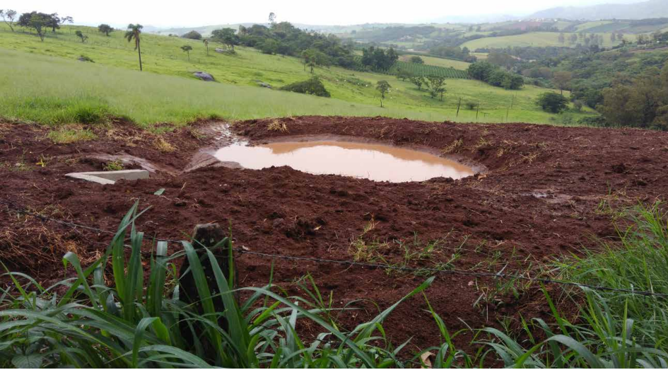
Figura 19: Antes e depois de uma construção de lombada
