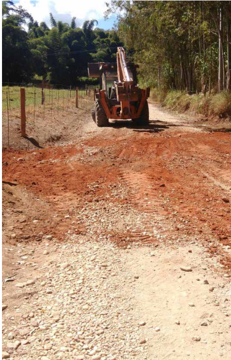
Figura 20: Compactação de cascalho
