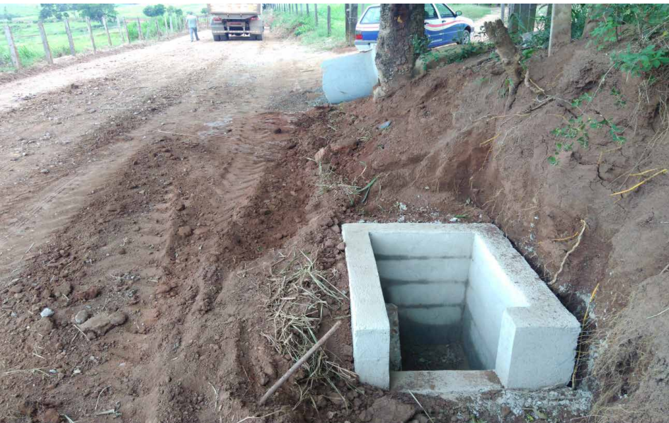
Figura 13: Caixa dissipadora de energia hidráulica
