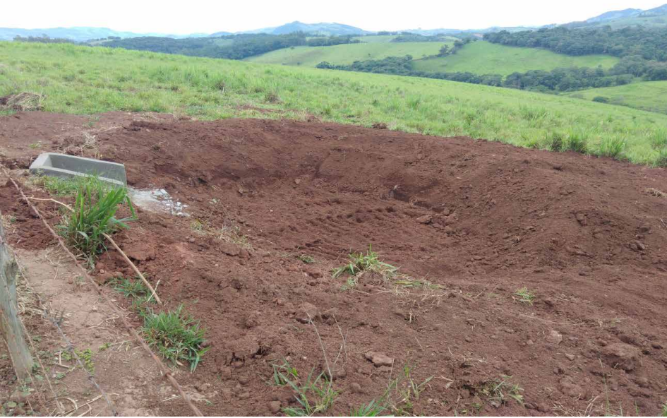
Figura 12: Caixa de retenção
