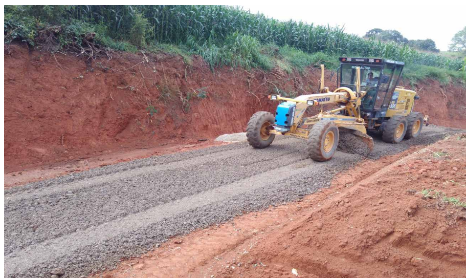
Figura 29: Cascalhamento e compactação da pista
