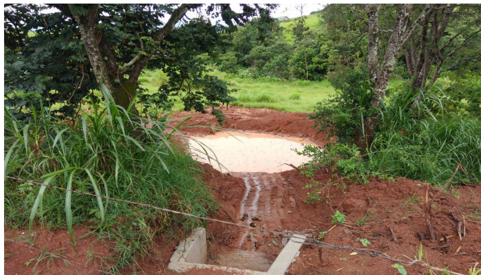
Figura 17: Obra de condução de água pluvial para caixa de contenção
