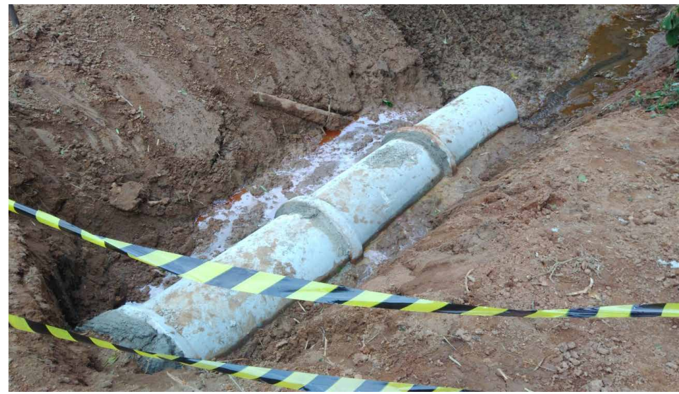
Figura 24: Instalação de tubulação de 0,60m para condução de água pluvial
