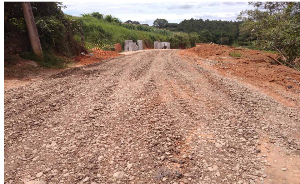
Figura 23: Instalação de tubulação de 0,60 m para condução de água pluvial
