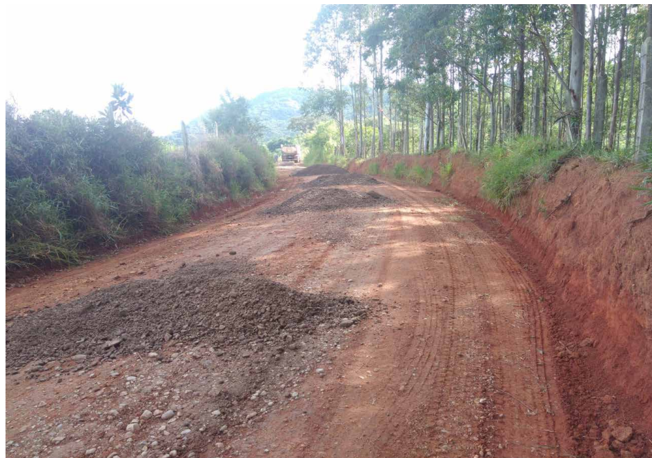
8.1 Estrada Municipal dos Cubas (SCR 235)
