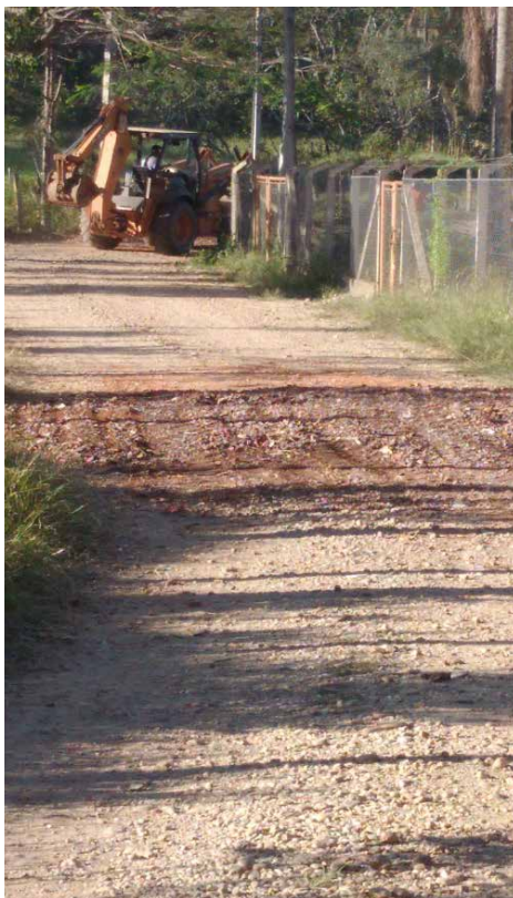
Figura 20: Compactação de cascalho
