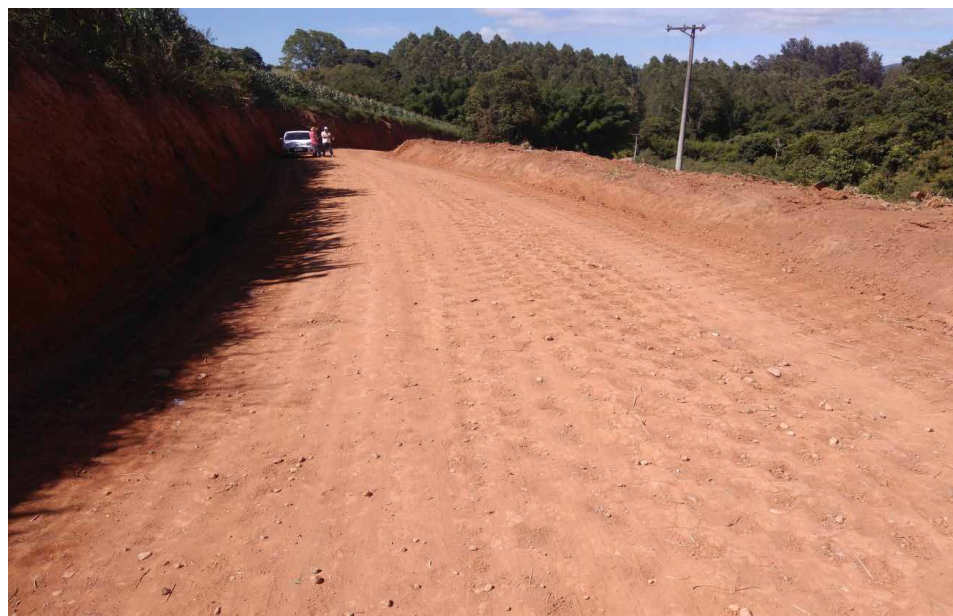
Figura 29: Cascalhamento e compactação da pista
