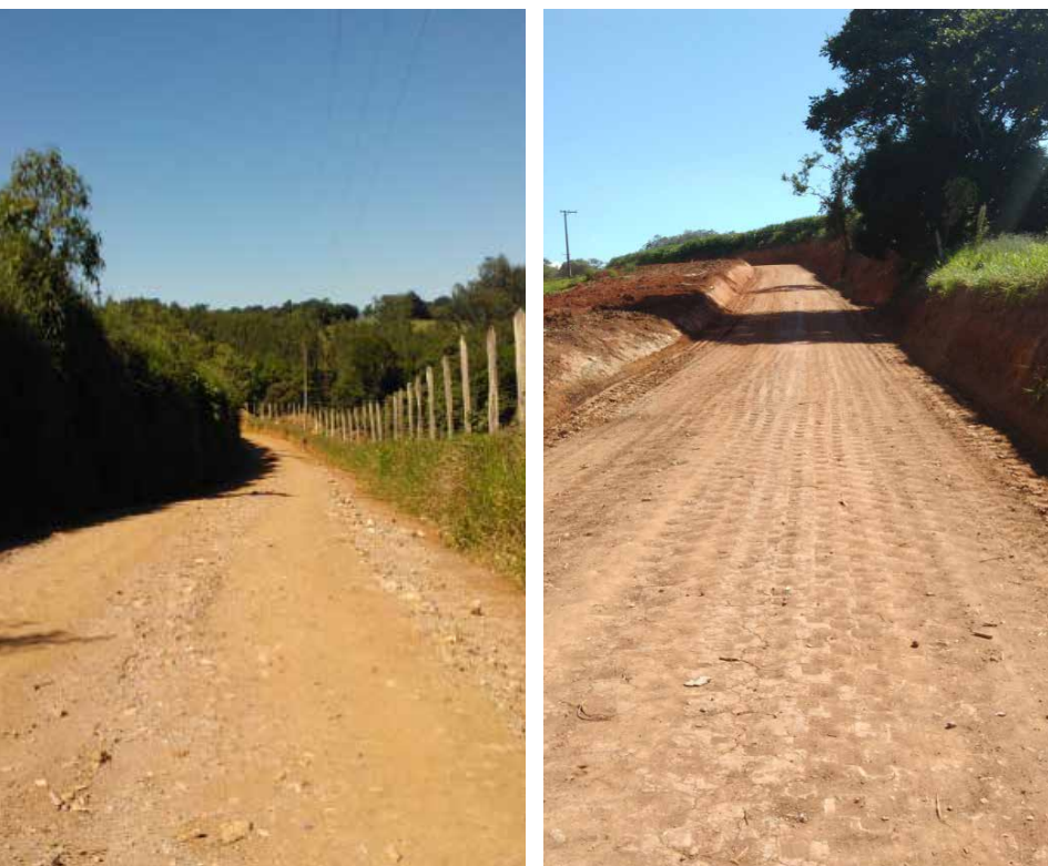
Figura 27: Antes e Depois do Abaloamento da pista
