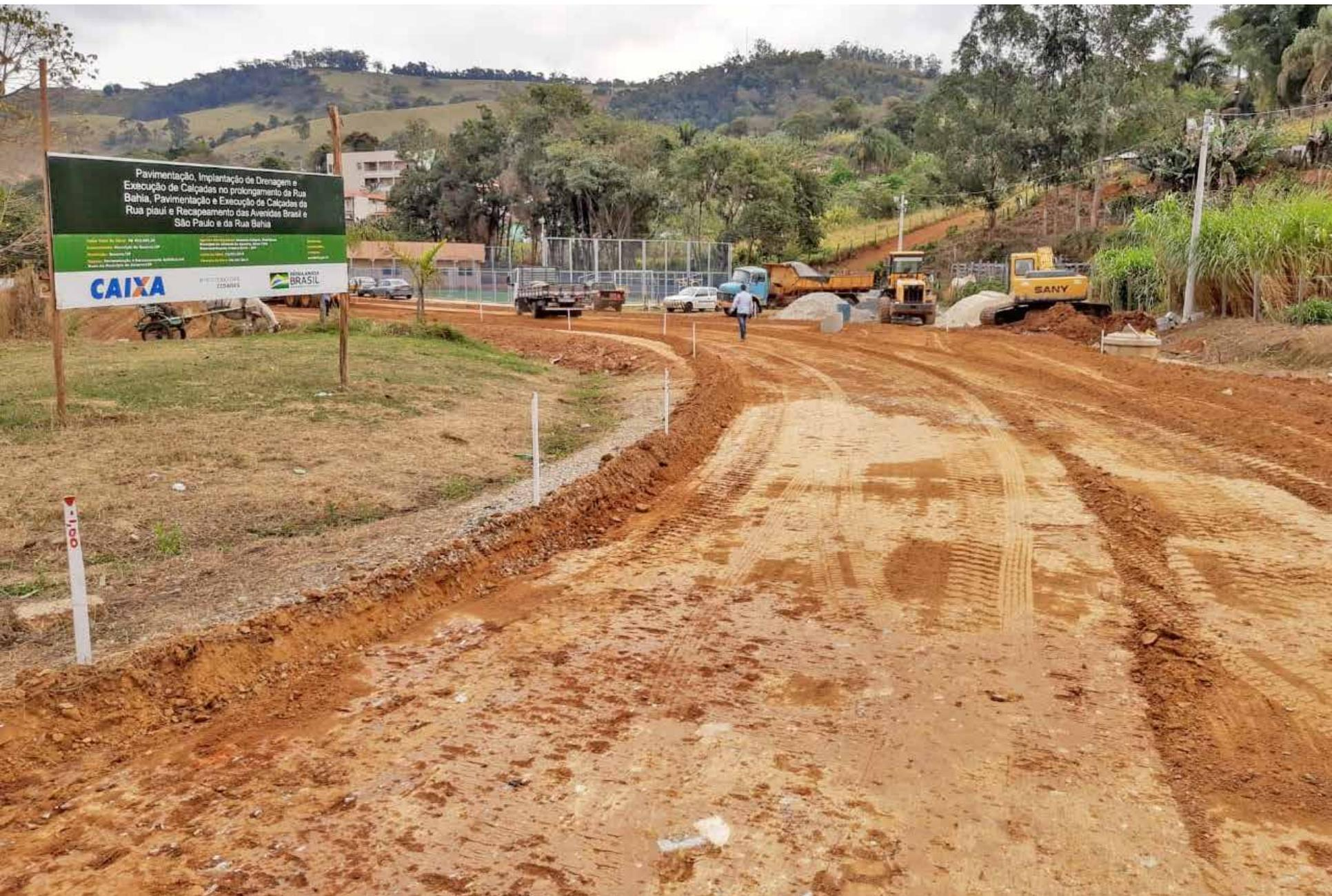
A Prefeitura de Socorro vem realizando diversas melhorias na infraestrutura urbana dentre elas, no Jardim Santa Cruz. As obras compreendem a implantação de sistema de captação e condução das águas pluviais, incluindo a instalação de linhas de tubulações, caixas coletoras, bocas
